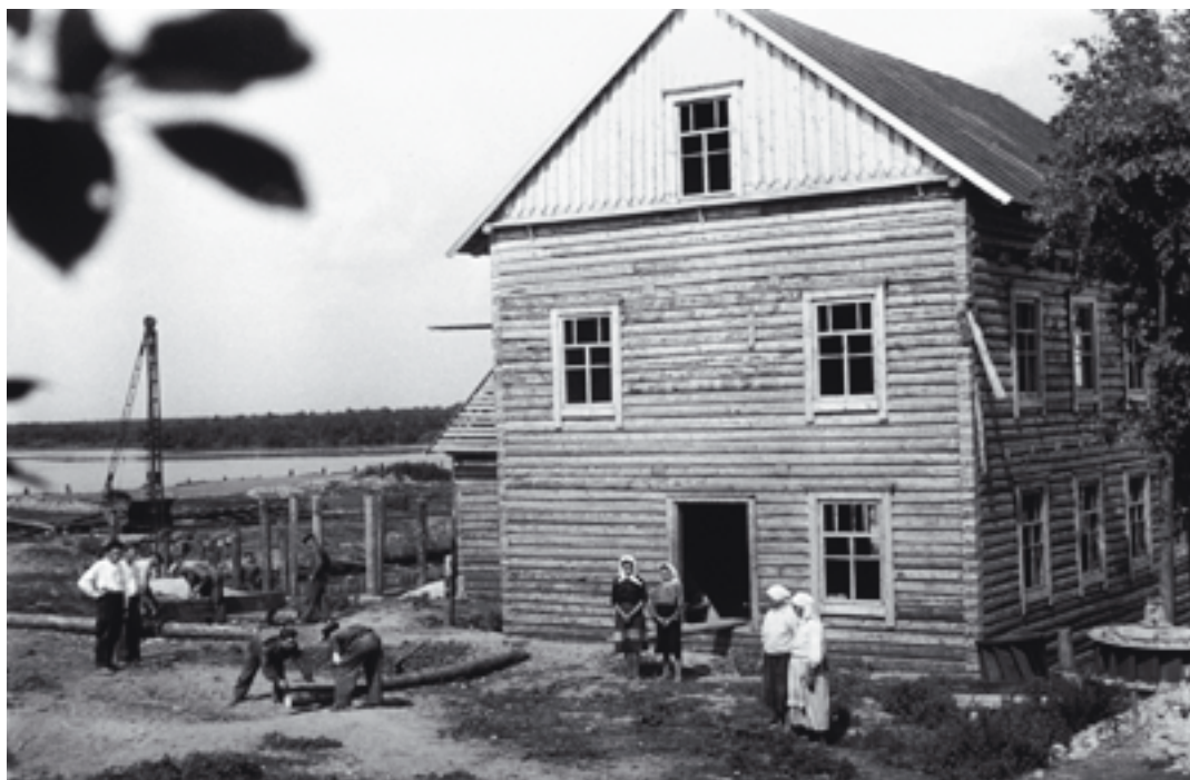
Строительство межколхозной гидроэлектростанции на реке Талица. Любанский район. 1949 г. БГАКФФД
